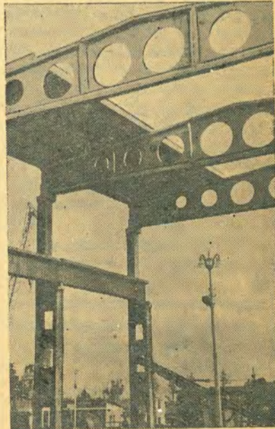
Напряженно-армированные составные балки.
