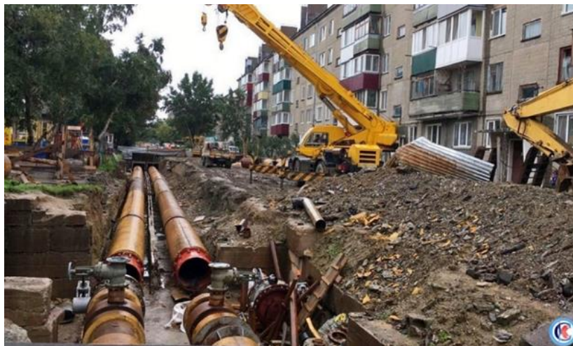
Рис. 1. Капитальный ремонт трубопровода открытым способом в городе Южно-Сахалинске
