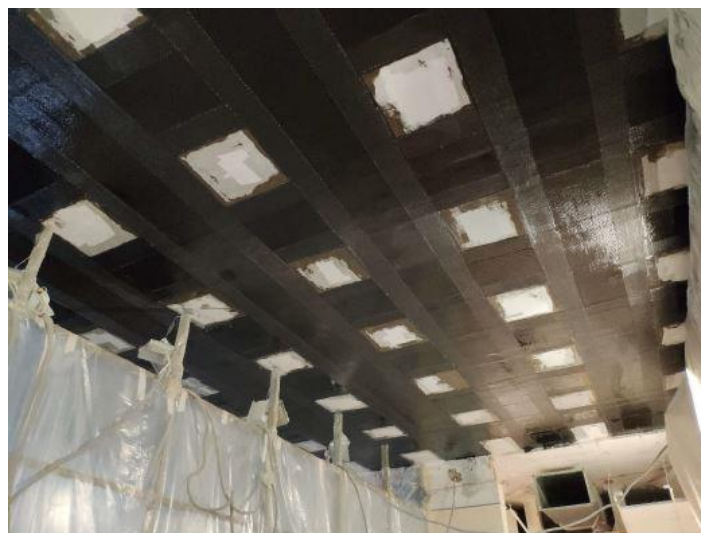
Рис. 1. Выполненное усиление на 1-ом участке
