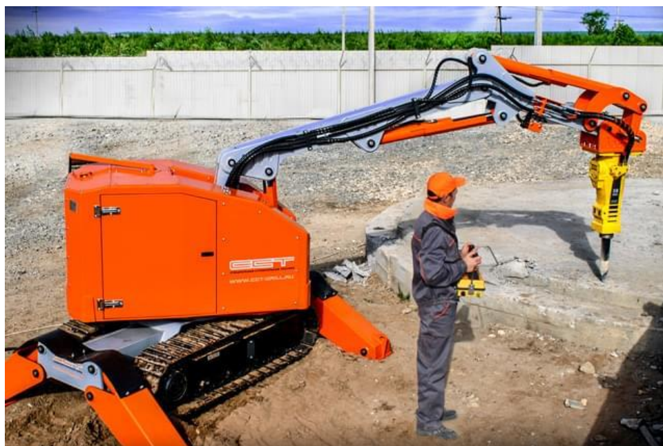
Рис. 2. Демонтаж бетона строительным роботом Атлант 4000
