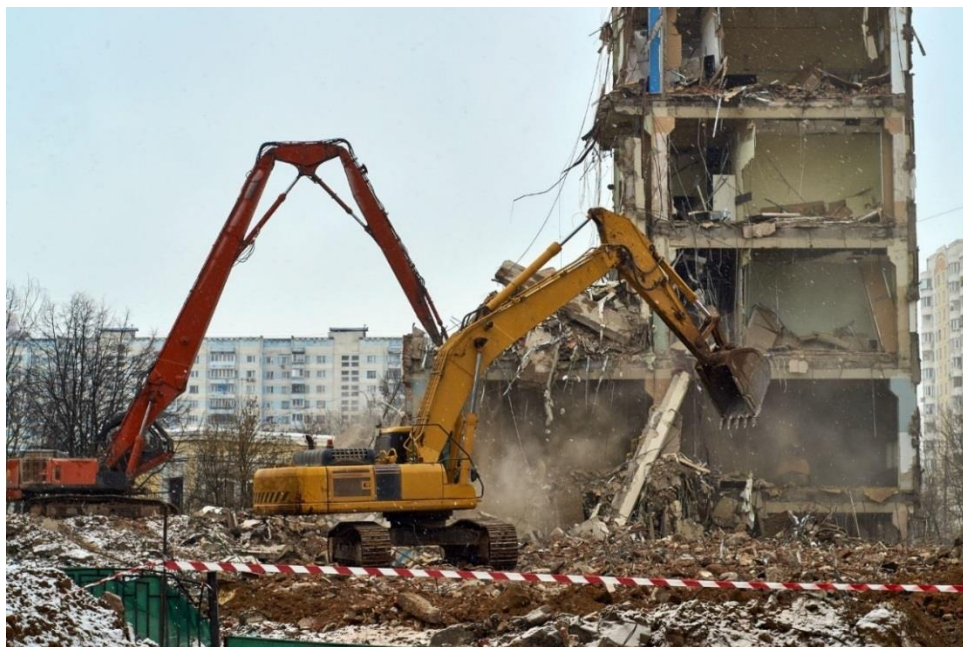
Рис. 1. Механизированный метод сноса с применением экскаватора
