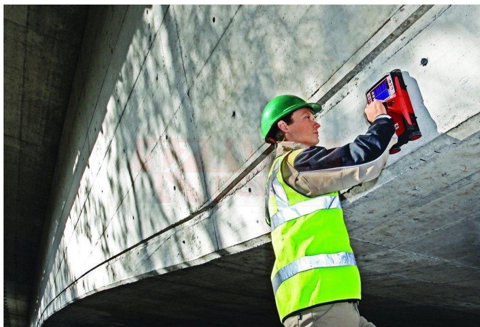
Рис. 2. Система PS 1000 X-SCAN при сканировании конструкции
