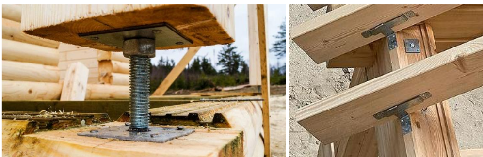
а б Рис. 2. Компенсаторы усадки стен:
