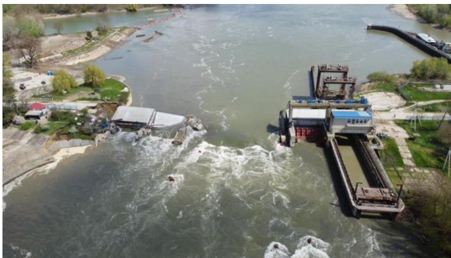
Рисунок 2. Состояние сооружений Фёдоровского гидроузла в один из моментов развития аварии [5]
