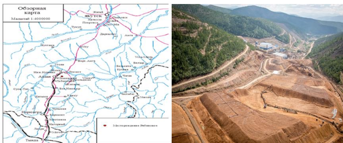
Рисунок 4. Пульпопровод горно-обогатительного комплекса «Рябиновый»
