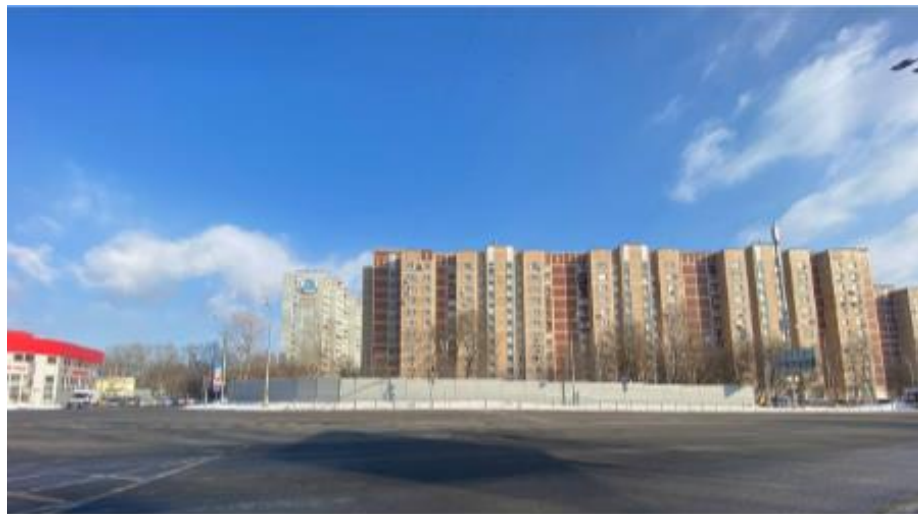
Рисунок 4. Вид на шумозащитные экраны со стороны Осташковской улицы
