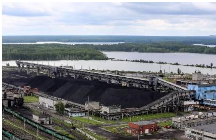
Рисунок 5. Склад угля на Рефтинской ГРЭС
