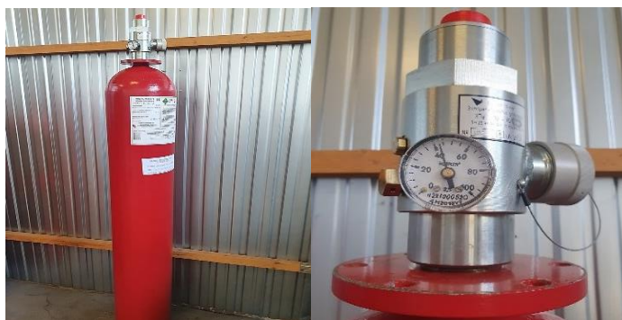
Рисунок 1. Внешний вид и устройство контроля давления модуля SNRX2
