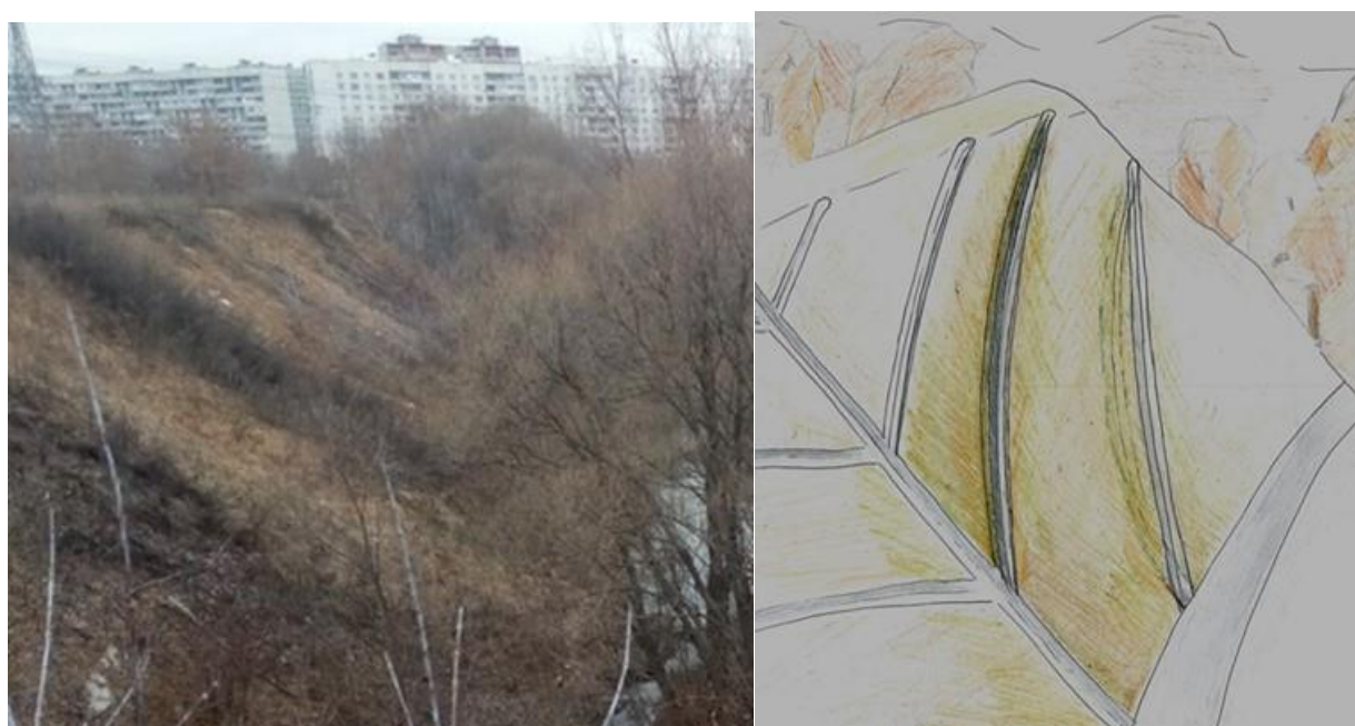
Рисунок 5. Профилактические меры борьбы с оползневыми процессами
