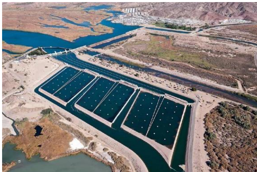
Рисунок 4. Перераспределение вод на Имперской плотине, обеспечивающее доставку воды из реки Колорадо на фермы Империял-Вэлли (по www.britannica.com )
