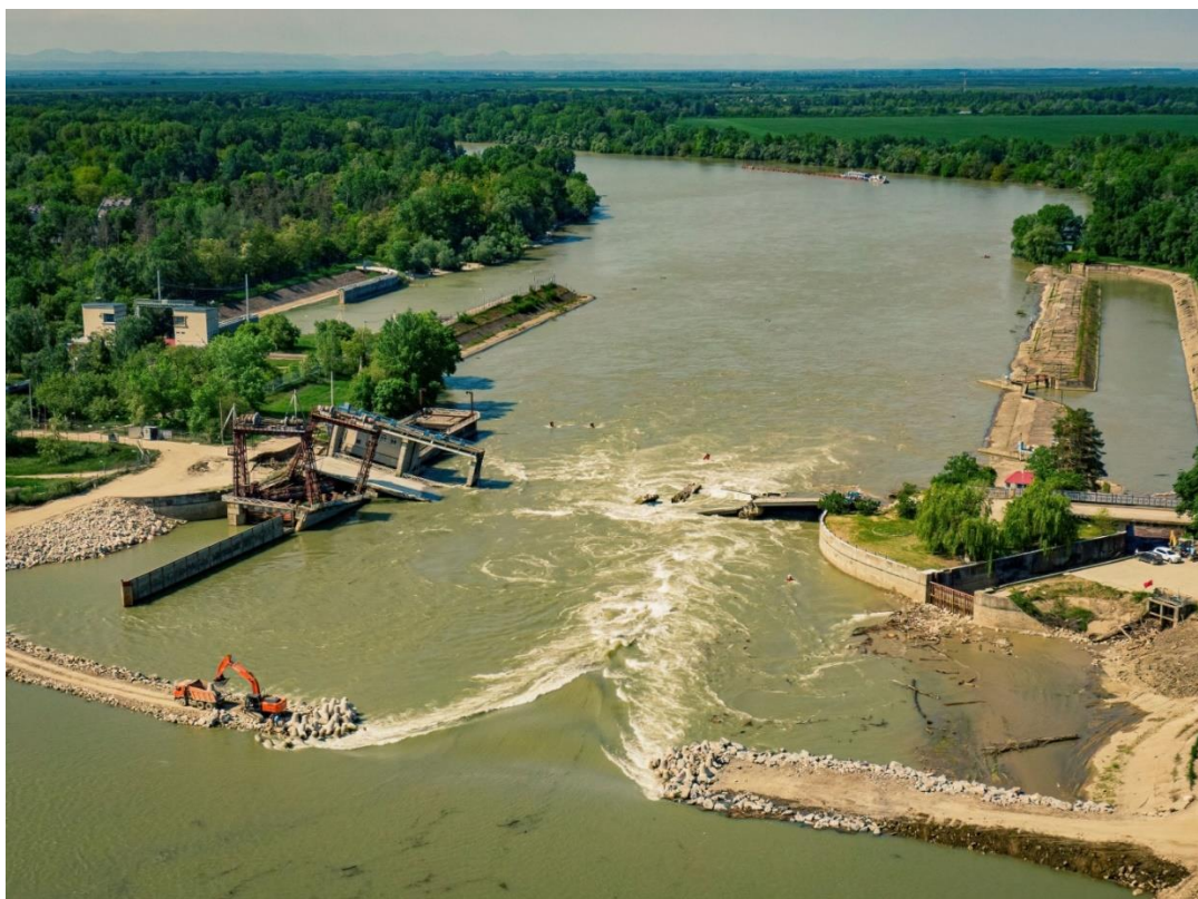
Рисунок 3. Вид водосливного прорана во временной плотине [6]
