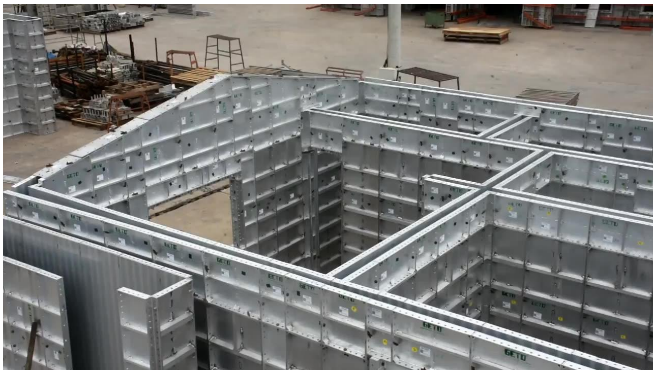
Рисунок 2. Устройство стен металлической щитовой опалубки с магнитным замком.
