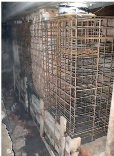
*Рис. 4. Устройство арматурного каркаса дополнительного железобетонного фундамента под резинометаллическую опору*
