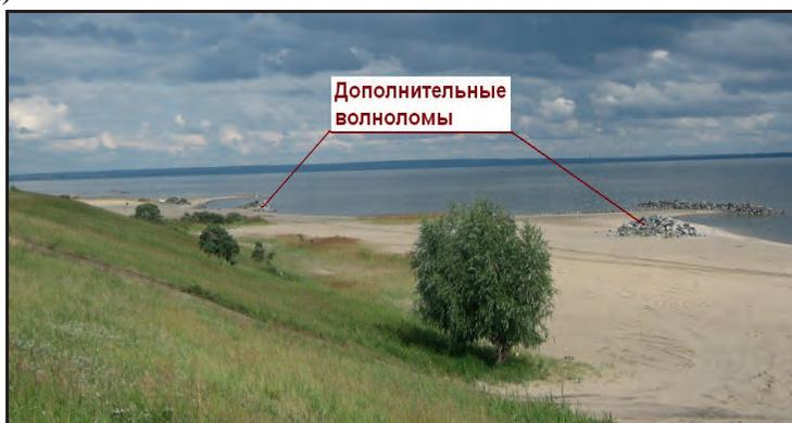
*Рис. 2. Пляжи с искусственными мысами под защитой волноломов (Новосибирское водохранилище)*
