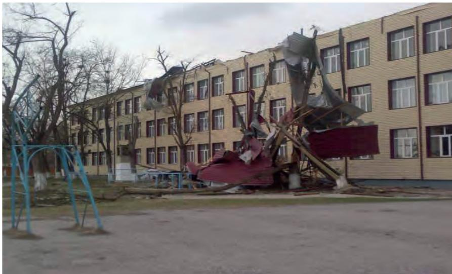
*Рис. 9. Последствия урагана 17 марта 2014 года. Разрушение металлической кровли здания школы*
