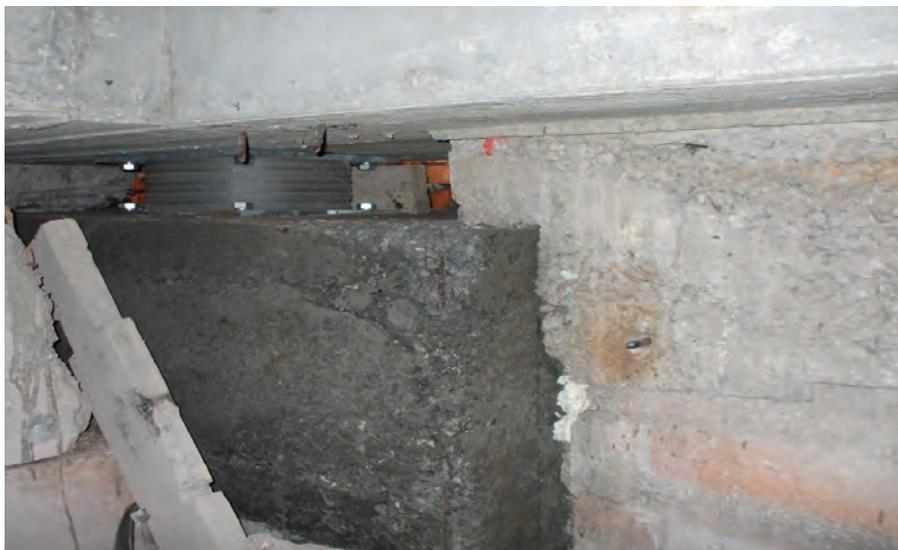
*Рис. 6. Установка резинометаллической опоры в проектное положение*
