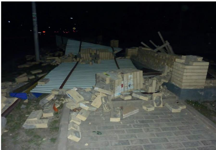
*Рис. 8. Последствия урагана 17 марта 2014 года. Опрокидывание металлического забора и разрушение кирпичных столбов*
