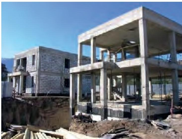
Наиболее рациональной является монолитно-каркасная конструктивная схема, состоящая из фундаментной плиты, колонн, перекрытий и кровельной части. Создание каркаса с монолитными перекрытиями обеспечивает неизменяемость здания. Технология возведения ведется поточным методом, что обеспечивает сокращение продолжительности работ и их совмещение во времени.
