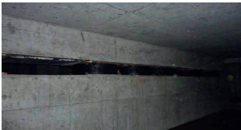
*Рис. 8. Подвальная часть 40-этажного здания «Грозный-Сити 1». Сейсмоизолирующие резинометаллические опоры в проектом положении*
