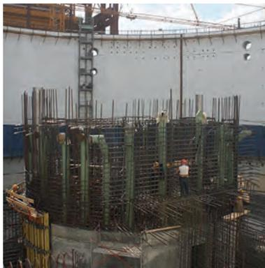
*Рис. 1. Монтаж устройства локализации расплава активной зоны*
