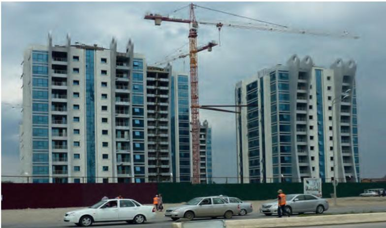
*Рис. 9. Комплекс зданий Аргун Сити-1, возведенных на сейсмоизолирующих промежуточных грунтовых подушках*
