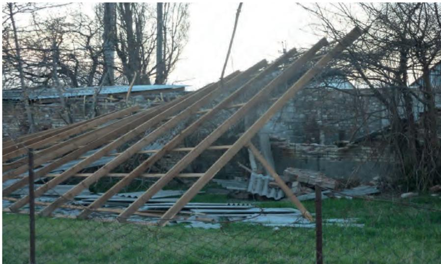
*Рис. 7. Последствия урагана 17 марта 2014 года. Разрушение покрытия одноэтажного здания*
