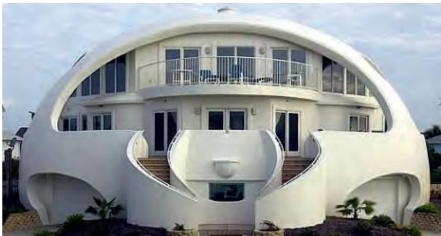
*Рис. 1. Вариант здания с ограждающими конструкциями в виде оболочки с регулируемыми теплофизическими свойствами*
