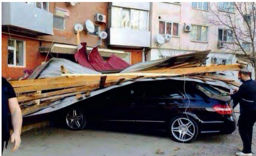
*Рис. 10. Последствия урагана 17 марта 2014 года. Обрушение металлической кровли жилого дома*
