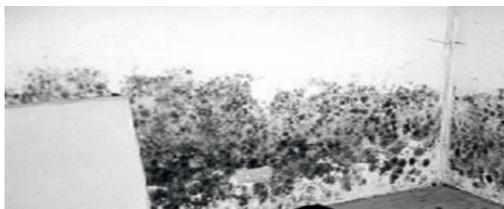
*Рис 1. Выпадение конденсата и появление плесени на внутренней поверхности стены при не соблюдении влажностного режима ограждающей конструкции*
