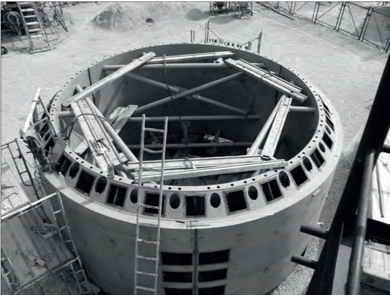
*Рис. 2. Металлоконструкция бакового варианта сухой защиты*
