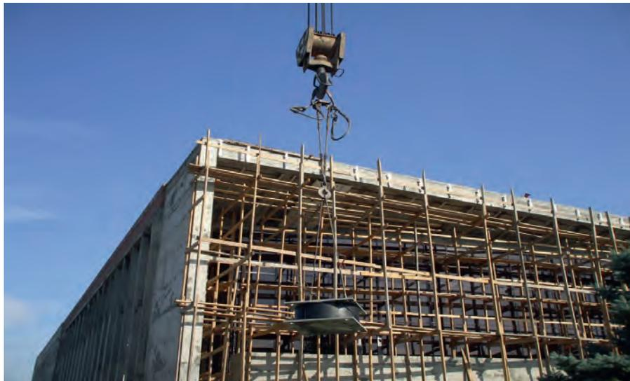
*Рис. 5. Доставка резинометаллической опоры к месту монтажа*
