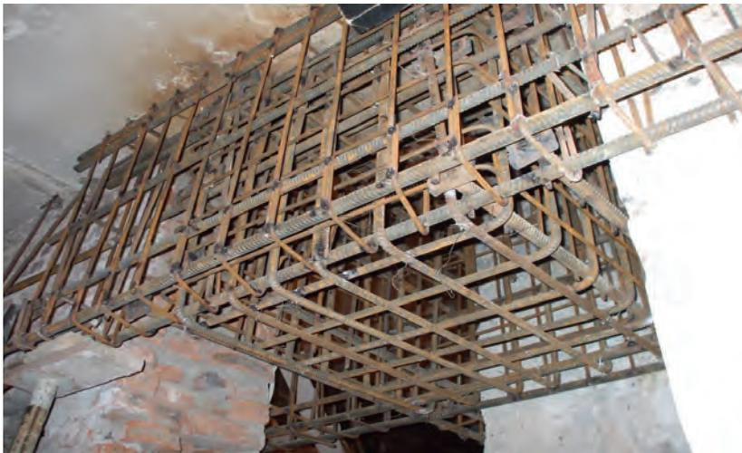
*Рис. 3. Монтаж арматурного каркаса перекрестной железобетонной балки*
